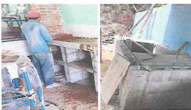
Instalacion de azulejos y realizacion de pila para el área de cocina
