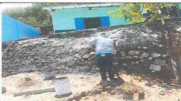
Protección de talud con electromaya y recubrimiento de concreto
