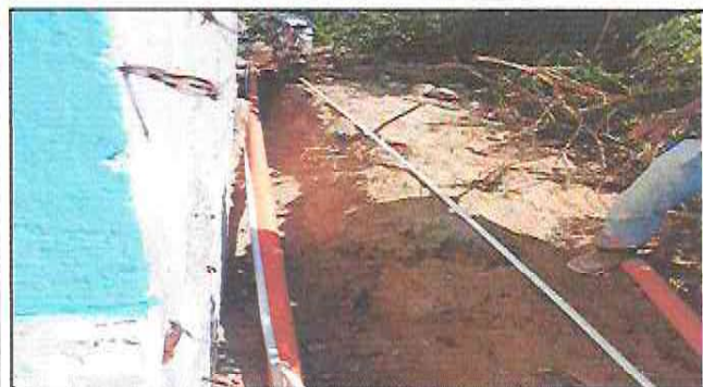
Red de agua potable, sustitucion de tubería línea principal
