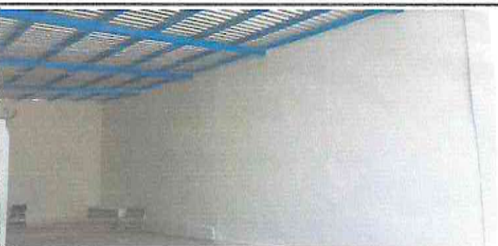
Foto 4: Techo reforzado con vigas de tubo cuadrado de una sola pieza y costaneras a una distancia corta entrea cada una de ellas, para mayor firmeza.
