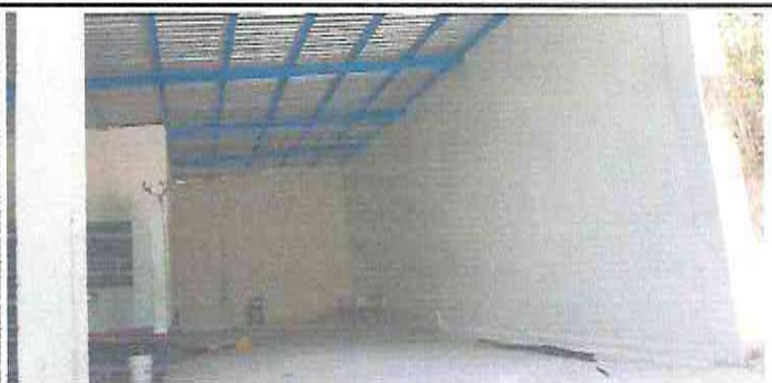
Foto 2: Areas de repello y cernido producto del remozamiento
