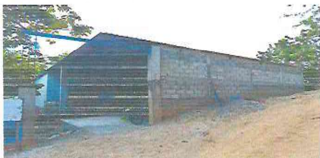
Foto 1: Vista desde la calle principal, donde se parecía que el techo esta terminado en su totalidad
