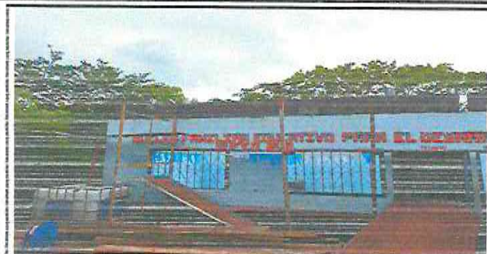
Foto 1: Levantamiento de paredes en el corredor para llegar a la altura estimada del techo nuevo
