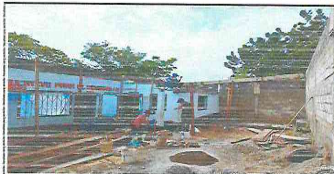
Foto 3: Fundición de vigas de concreto con la pendiente requerida para colocar la estructura de metal para el techo
