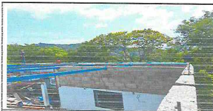
Foto 5: Colocación e costaneras
