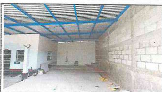
Foto: Techo finalizado, repello y cernido en la última fase
