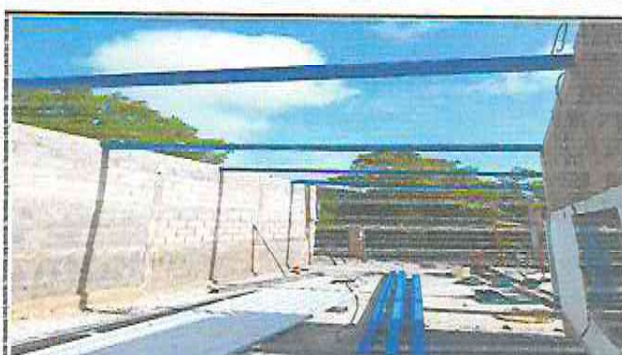
Foto 4: Colocación de vigas de acero, para colocar las costaneras y la lamina troquelada
