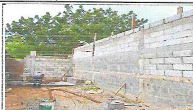
Foto 2: Levantamiento de paredes, que da a la calle y al fondo con el vecino
