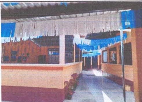
Foto 3: Mantenimiento a estructura de balcones de metal
