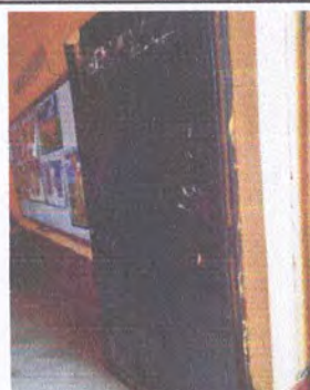
Foto 4: Mantenimiento a estructuras de puertas de metal
