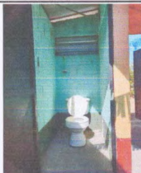
Foto 11: Aplicación de pintura en área de baños
