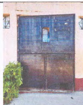
Foto 16: Mantenimiento a porton de metal
