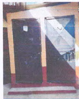
Foto 8: Mantenimiento a estructuras de puertas de metal
