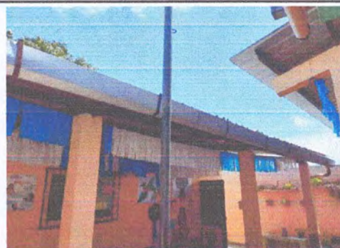
Foto 12: Sustitución de canal de metal
