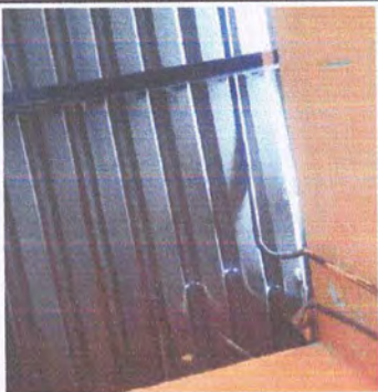
Foto 1: Sustrucción de lámina, por lámina troquelada aluzinc con tornillera de fijación
