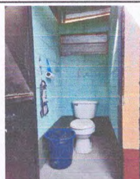
Foto 10: Sustitución o Instalación de piso cerámico en sanitarios
