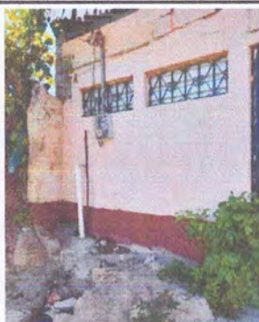
Foto 15: Pintura en muros exteriores
