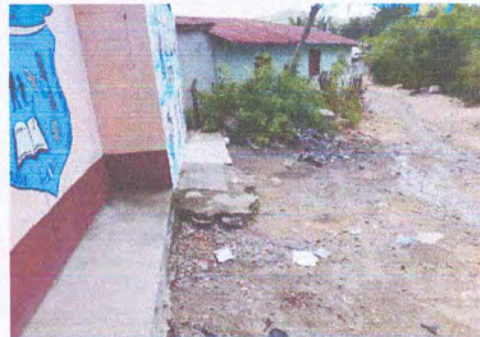
Foto 14: Reparación de banquetas de concreto
