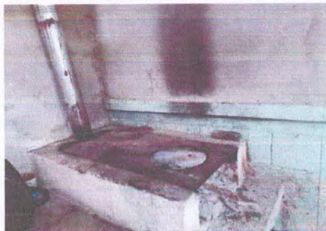
Foto 5: Mantenimiento de estufa rural
