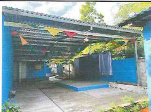
Foto 3: estructura de soporte y sustitucion de lamina terminado
