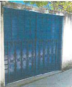
Foto 6: mantenimiento de Portón de ingreso terminado
