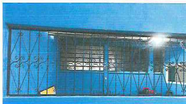
Foto 8: sustitucion de balcones terminados
