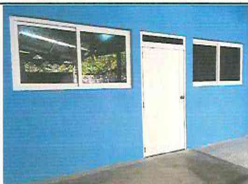
Foto 9: pared de block terminada con ventanas de PVC y puerta PVC instaladas
