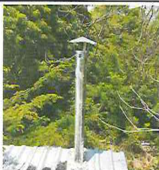
Foto 5: estufa rural completa terminada (chimenea)
