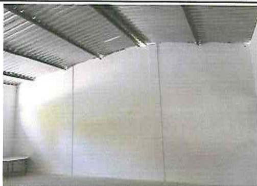
Foto1: repello y cernido de paredes de salon de clases (interior) terminado
