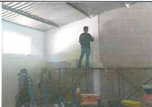
Foto1: repello y cernido de paredes de salon de clases (interior)
