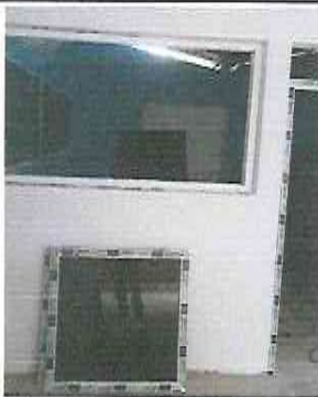
Foto 9: instalacion de ventanas PVC
