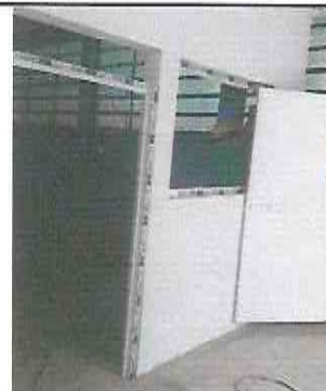
Foto 10: instalacion de puertas PVC
