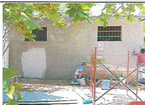
Foto 2: repello y cernido de paredes de salon de clases (exterior)
