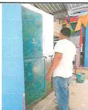
Foto 5: mantenimiento de puertas de metal
