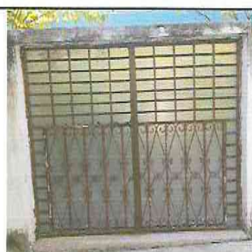
Foto 6: Mantenimiento de portón
