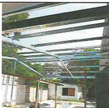
Foto 3: proceso de sustitucion de estructura de soporte y sustitucion de lamina
