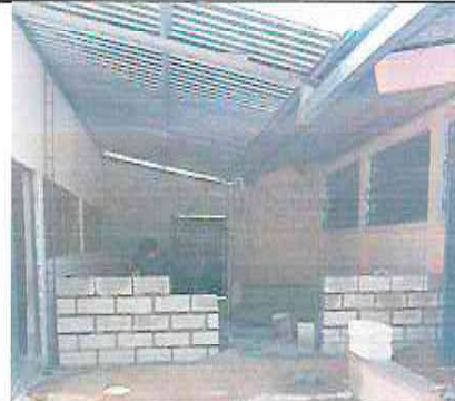
Foto 8: sustitución de pared de block
