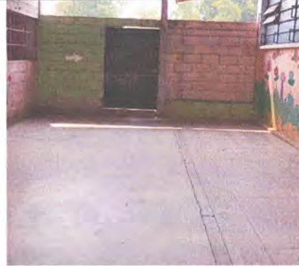
FOTO 8: sustrucion o instalacion de pared de block
