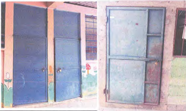
FOTO 5: puertas para mantenimiento (lijado y pintura)
