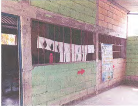
FOTO 7: Sustrucion de balcones
