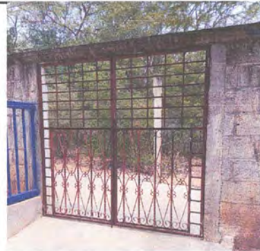
FOTO 6: porton para mantenimiento
