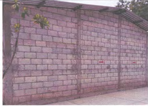
FOTO 2: paredes exteriores de salon de clases para repello y cernido
