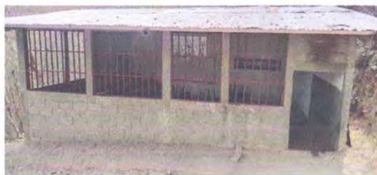
1.4 Colocacion de canal
