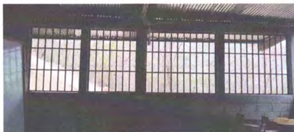
1.7 Mantenimiento de balcones de metal
