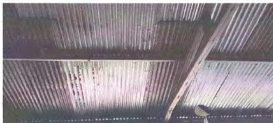
1.5 Sustitucion de lamina por lamina troquelada
