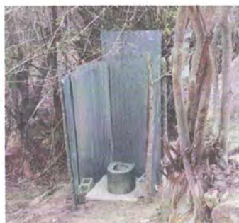
3. Reconstruccion del sanitario
