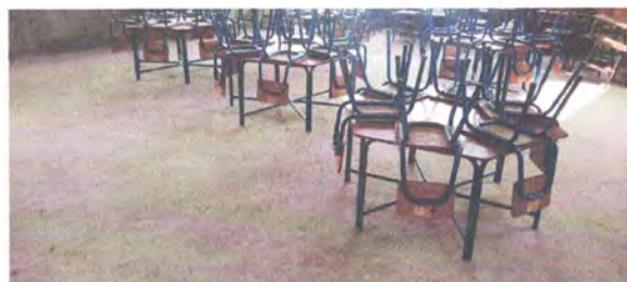
1.8 Colocacion de piso ceramico en aula
