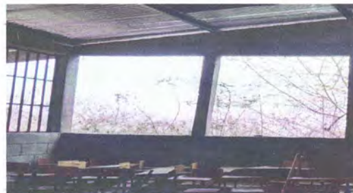
1.6 Colocacion de balcones de metal
