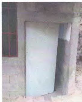
1.10 Elaboracion de puerta de metal
