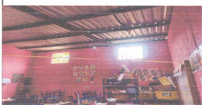
Foto 3: Cambio de lamina ,costanera, y ampalcion de ventanas
