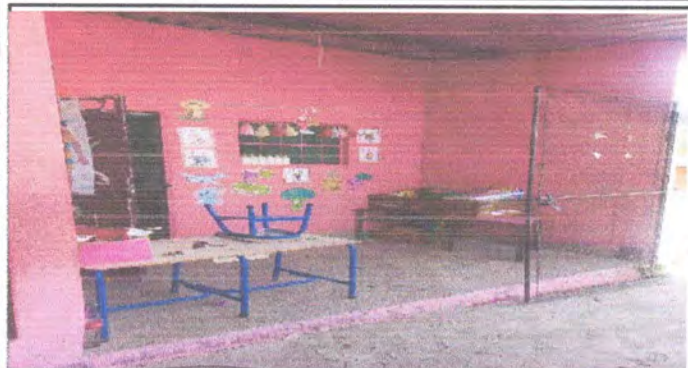
Foto1: Amplacion de aula #1. Colocacion de piso ceramico
