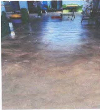
Foto1: INSTALACION DE PISO CERAMICO MATE DE ALTA RECISTENCIA DE PEI 4.
