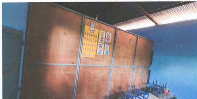
FOTO 7: MEJORAMIENTO PREFABRICADO DE PLANCHAS DE CEMENTO.
