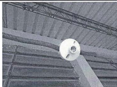
Foto 5: instalaciones electricas en mal estado, necesita una intervencion total en todo el centro educativo, se agrega la instalacion de 20 unidades de iluminacion.
