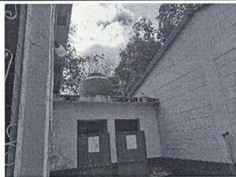
Foto 6: losa que presenta humedad y fugas de agua, se debera realizar reparacion de tuberia de agua y accesorios del tinaco.
