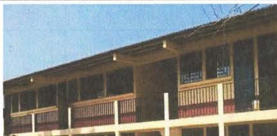
Pintura general de balcones
