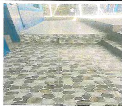
Foto 10: Instalación de piso cerámico en corredor
