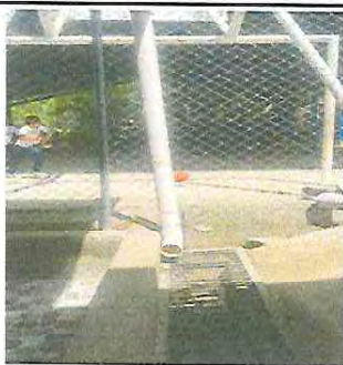
Foto 11: Reparación de bajada de agua pluvial
