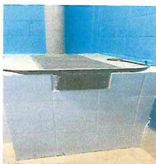
Foto 5: Polletón con estufa ahorradora y chimenea de concreto
