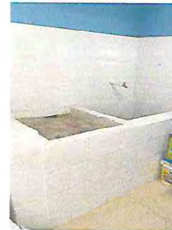
Foto 14: Reparación de pila e instalación de azulejo.
