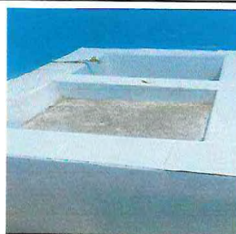
Foto 6: Sustitución de Pila Plástica por concreto.
