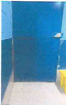
Foto 15: Sustitución de puerta.
