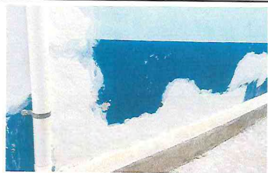
Foto 16: Reparación de pila e instalación de azulejo.
