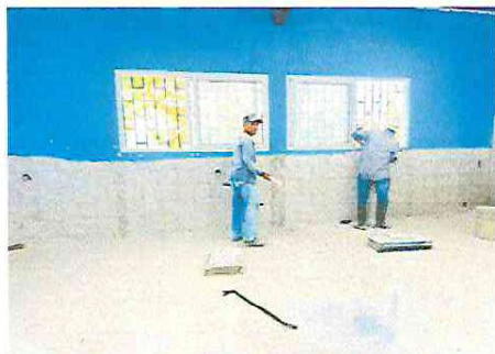
Foto 1: Demolición de cernido y colocar cernido nuevo en paredes con hongo.
