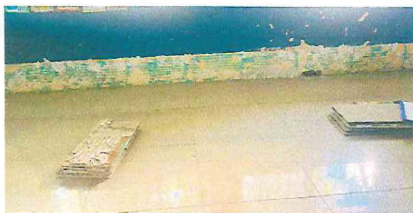
Foto 3: Retirar zócalo mal colocado limpiar e instalar el mismo
