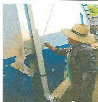
Foto 16: Reparación de pila e instalación de azulejo.
