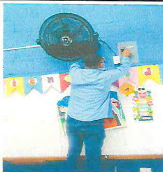
Foto 12: Sustitución de ventiladores
