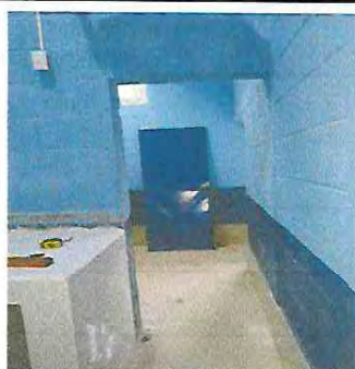
Foto 15: Sustitución de puerta.
