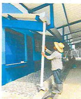
Foto 11: Reparación de bajada de agua pluvial
