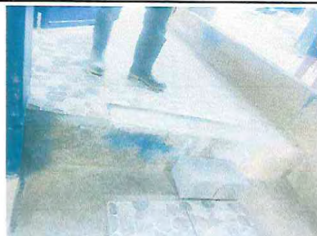
Foto 10: Instalación de piso cerámico en corredor
