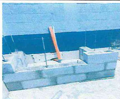
Foto 6: Sustitución de Pila Plástica por concreto.
