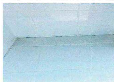
Foto 14: Reparación de pila e instalación de azulejo.
