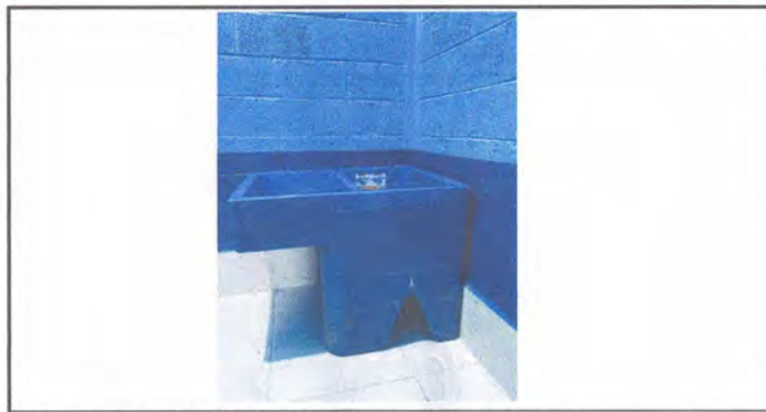
Foto 6: Sustitución de Pila Plástica por concreto. ✓
