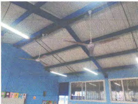
Foto 17: Sustitución de ventiladores
