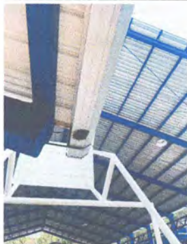
Foto 11: Reparación de bajada de agua pluvial
