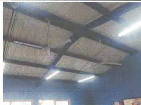
Foto 12: Sustitución de ventiladores
