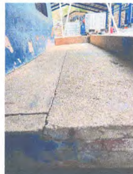
Foto 10: Instalación de piso cerámico en corredor
