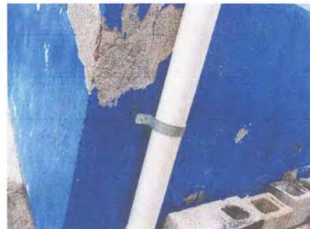
Foto 16: Reparación de pila e instalación de azulejo.
