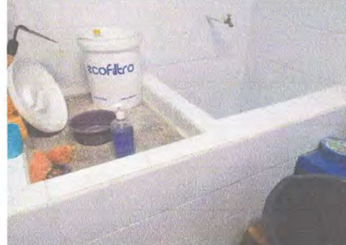
Foto 14: Reparación de pila e instalación de azulejo.
