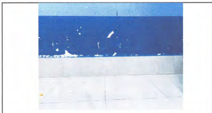
Foto 3: Retirar zócalo mal colocado limpiar e instalar el mismo. ✓
