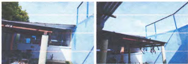
sustitución de lamina troquelada
