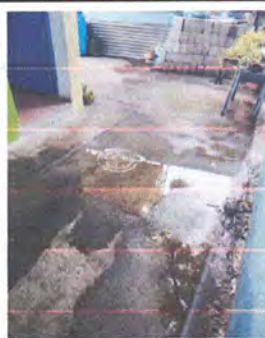
limpieza, vaciado e instalación de cifon en fosa septica, sale mal olor por estar llena
