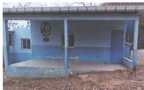
foto 12: Barandal en corredor de escuela
