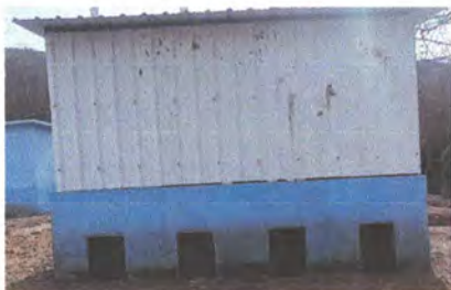
foto 1: Instalación de drenaje de baño
