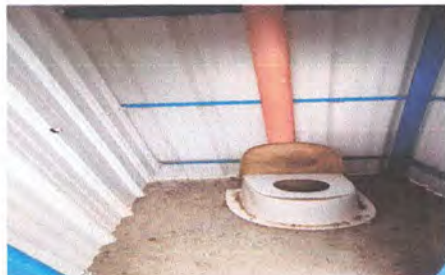
foto 3: Sustitución de sanitarios
