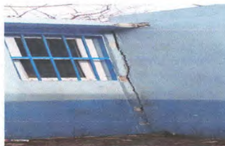
foto 6: Sellar grietas en las paredes
