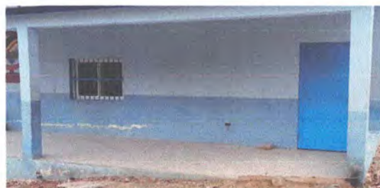
foto 8: Levantado de muro en área de corredor de la escuela
