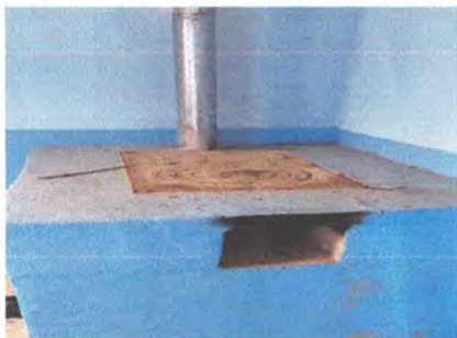
foto 5: Sustitución de chimenea
