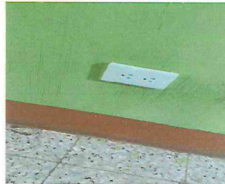
Foto 2. POSTERIOR: Instalación de 500 metros lineales de cable eléctrico, 44 tomacorrientes y 12 interruptores en el INEB JM, Huité.
