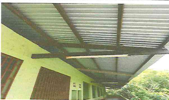
Foto 5. POSTERIOR: Sustitución de techos de aulas del segundo nivel con lámina troquelada calibre 26.
