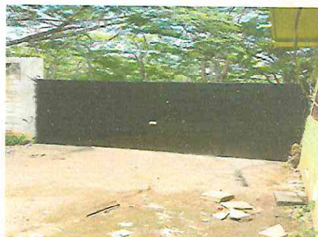
Foto 8: POSTERIOR: Reparación Portón de entrada principal consistente en lijarse y pintar.
