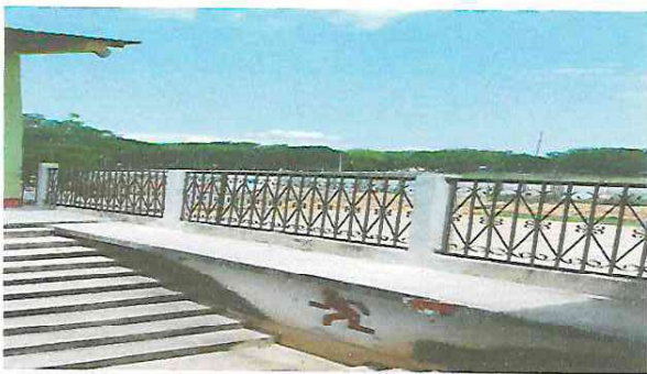
Foto 3. POSTERIOR: Mantenimiento de baranda de metal lijada, pintada y reforzada con cuatro columnas.
