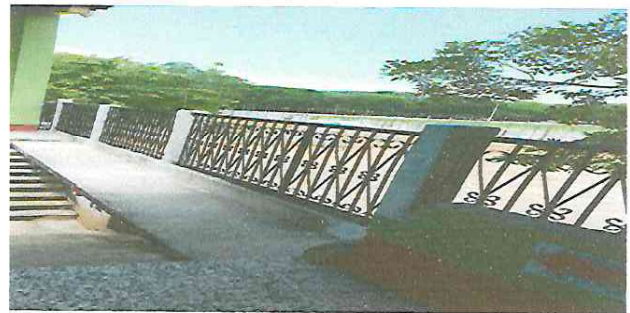
Foto 4. POSTERIOR: Mantenimiento de baranda de metal lijada, pintada y reforzada con cuatro columnas.
