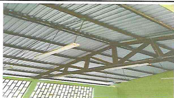
Foto 6. POSTERIOR: Sustitución de techos de aulas del segundo nivel con lámina troquelada calibre 26.
