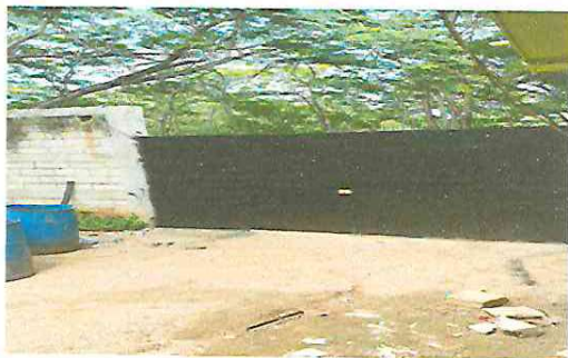
Foto 7: POSTERIOR: Reparación Portón de entrada principal, consistente en lijarse y pintar.
