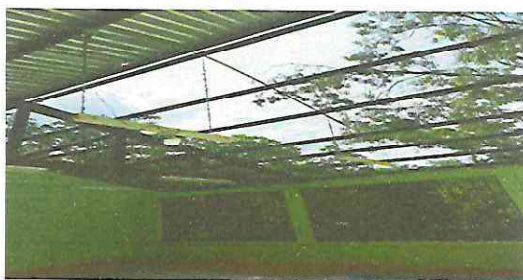
Foto 5: DURANTE: Sustitución de techos de aulas del segundo nivel con lámina troquelada calibre 26.
