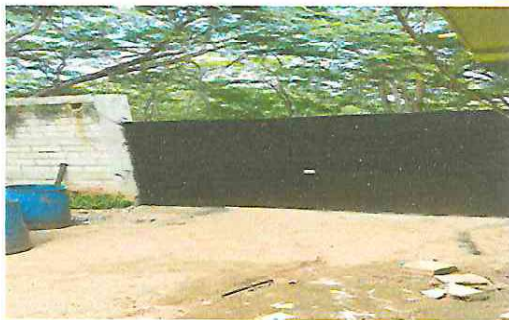
Foto 7: DURANTE: Reparación Portón de entrada principal, consistente en lijar y pintar.
