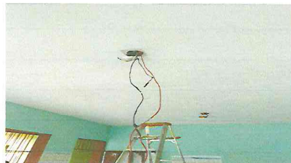
Foto 2: DURANTE instalación de 500 metros lineales de cable eléctrico, 44 tomacorrientes y 12 interruptores en el INEB JM; Huité.
