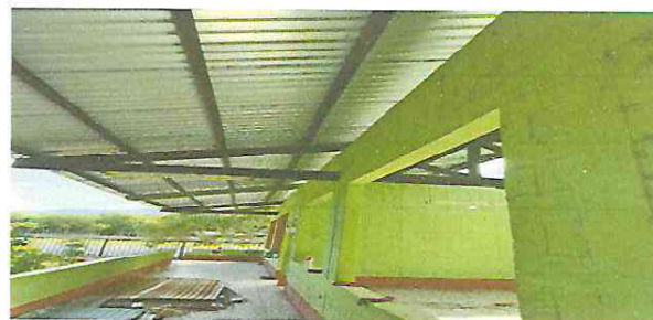
Foto 6: DURANTE: Sustitución de techos de aulas del segundo nivel con lámina troquelada calibre 26.
