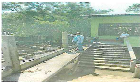
Foto 3: DURANTE: Mantenimiento de baranda de metal lijada, pintada, y reforzada con cuatro columnas.
