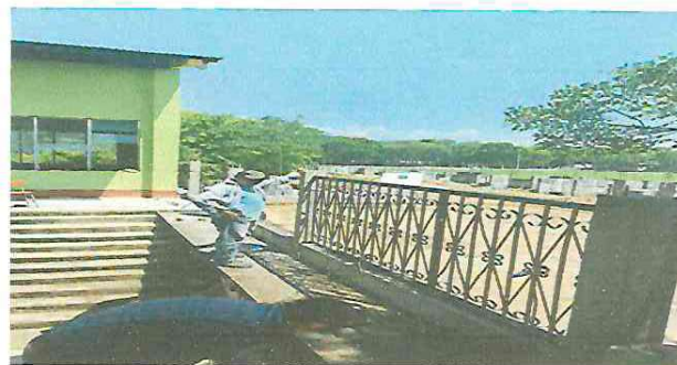
Foto 4: DURANTE: Mantenimiento de baranda de metal, lijada, pintada y reforzada con cuatro columnas.
