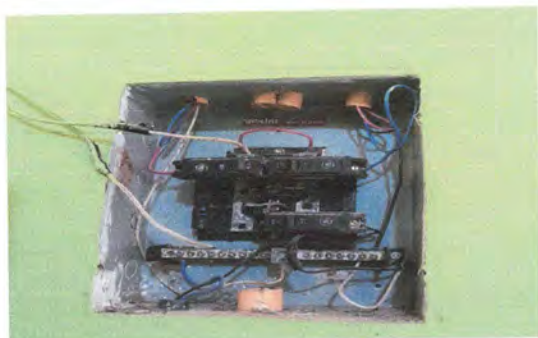
Foto 3: En esta imagen se aprecia el aula número 2, Sustitución del cable eléctrico, tomacorrientes e interruptores en planta baja
