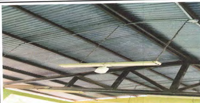
Foto 2: Sustitución de Techo en aulas del segundo nivel con lámina Troquelada calibre 26 legítima
