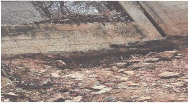
Foto 7: Protección de muro existente.
