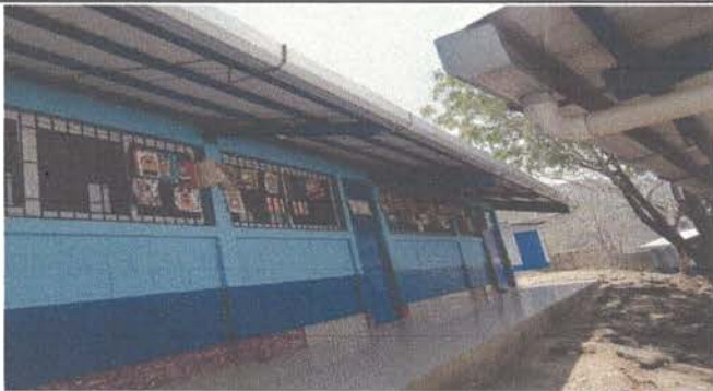
Foto 11: Cambio de canal pvc
