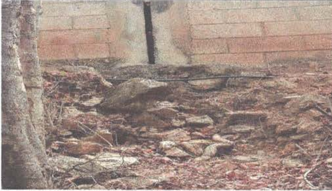
Foto 1: Protección de muro existente.
