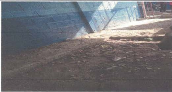
Foto 9: Fundición de torta de cemento en galera.
