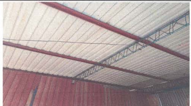
Foto 4: Sustitución de cable eléctrico en galera
