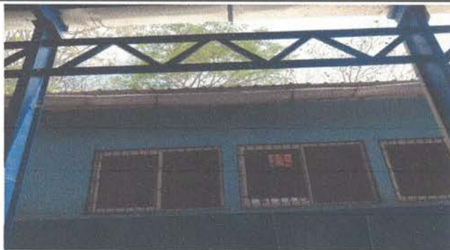
Foto 5: Cambio de canal pvc
