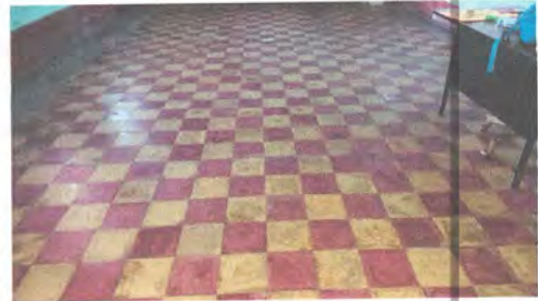
Foto 4: Reparacion de piso liquido por torta de cemento c en aula no.1
