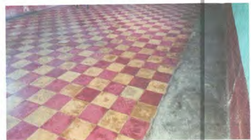
Foto 6: Reparación piso liquido por torta de concreto en aula no.1
