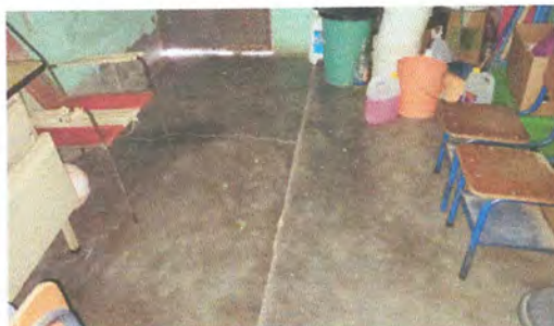
Foto 3: Reparación de piso liquido por torta de concreto en dirección del establecimiento.
