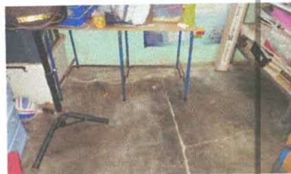
Foto 2: Reparación de piso liquido por torta de concreto en dirección del establecimiento.
