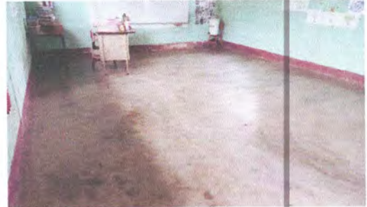
Foto 2: Reparación de piso líquido por torta de concreto en aula no.3
