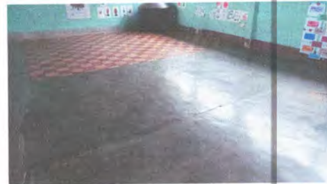
Foto 6: Reparación de piso liquido por torta de concreto en aula no. 2
