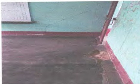
Foto 5: Reparación de piso liquido por torta de concreto en aula no. 2
