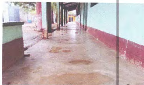
Foto 2: Reparación de piso liquido por torta de concreto en el corredor
