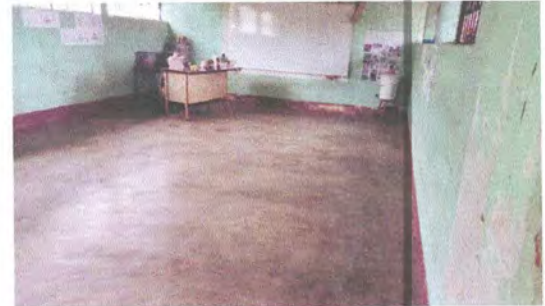
Foto 4: Reparación de piso líquido por torta de concreto en aula no.3
