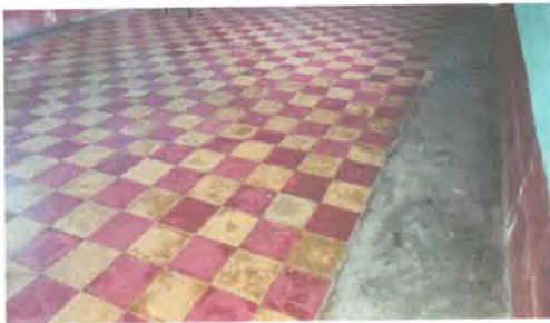
Foto 3: Reparación de piso liquido por torta de concreto en aula no.1
