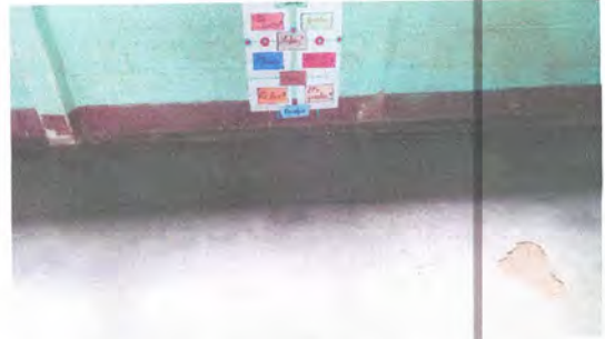
Foto2: Reparación de piso liquido por torta de concreto en aula no. 2
