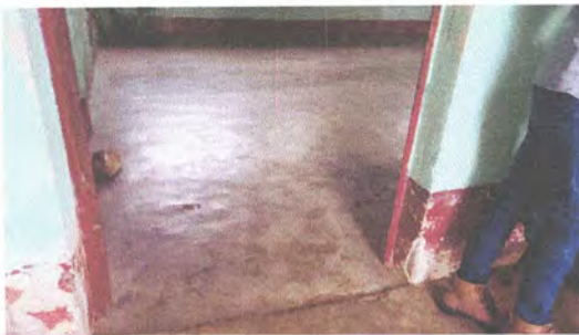
Foto 5: Reparación de piso líquido por torta de concreto en aula no. 3
