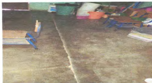
Foto 5: Reparación de piso liquido por torta de concreto en dirección del establecimiento.
