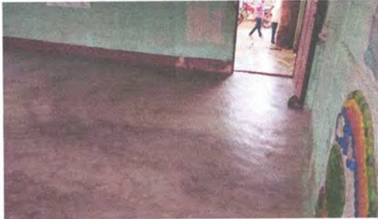
foto3: Reparación de piso líquido por torta de concreto en aula no.3
