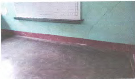
Foto 3: Reparación de piso liquido por torta de concreto en aula no. 2
