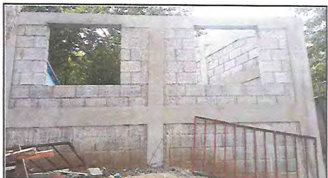
Foto 4: Sustrucción cerramiento de lámina por muro de mampostería reforzada.
