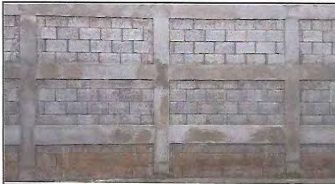
Foto 1: Sustrucción cerramiento de lámina por muro de mampostería reforzada.
