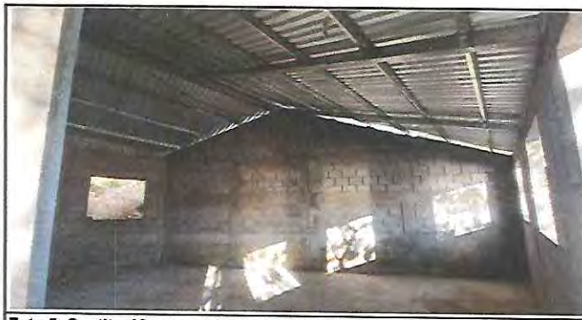
Foto 5: Sustrucción cerramiento de lámina por muro de mampostería reforzada.
