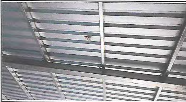
Foto 1: Sustitución de lámina por lámina troquelada aluzinc calibre 26 con tornillera de fijación, en el aula.
