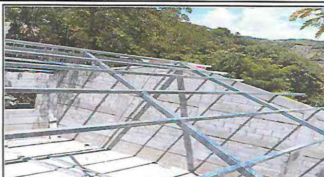
Foto 2: Sustrucción de estructura de soporte de madera, por metal en el aula.
