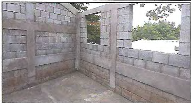
Foto 2: Sustrucción cerramiento de lámina por muro de mampostería reforzada.
