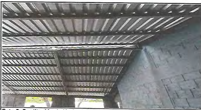
Foto 5: Sustitución de lámina por lámina troquelada aluzinc calibre 26 con tornillera de fijación, en el aula.
