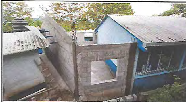
Foto 3: Sustrucción cerramiento de lámina por muro de mampostería reforzada.
