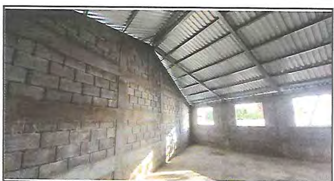
Foto 6: Sustrucción cerramiento de lámina por muro de mampostería reforzada.
