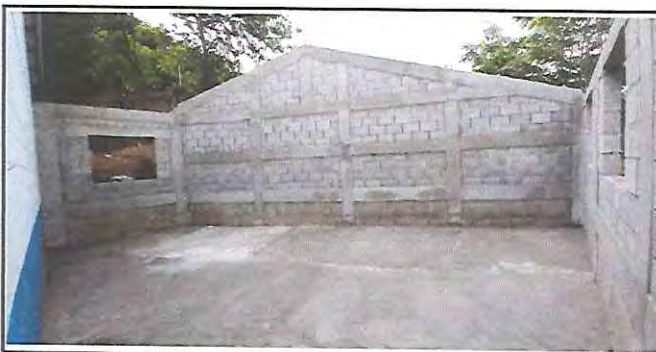
Foto 5: Sustitución de torta de concreto, en el aula.
