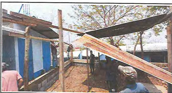
Foto 5: Trabajadores quitando el techo de lámina que se encontraba en malas condiciones.
