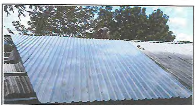
Foto 6: Herrero instalando la lámina troquelada aluzinc calibre 26 con tornillera de fijación, en el aula.
