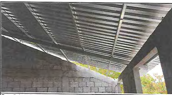
Foto 5: Instalación de lámina troquelada aluzinc calibre 26 con tornillera de fijación, en el aula.
