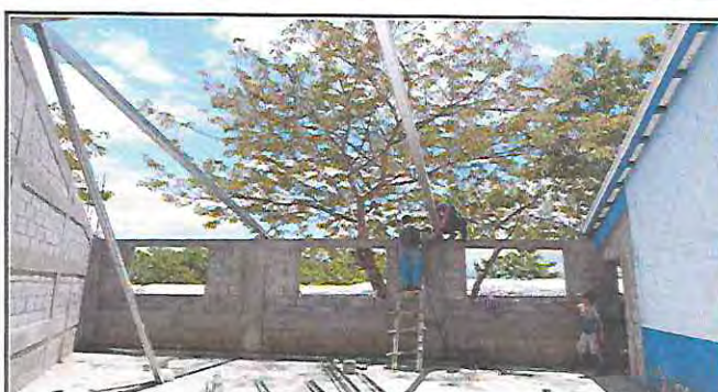
Foto 4: Herrero instalando los tubos cuadrados galvanizados, para sustituir la estructura de soporte de madera por metal, en el aula.
