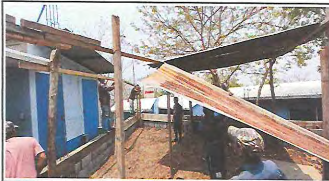
Foto 3: Trabajadores quitando la estructura de madera que se encontraba en malas condiciones.
