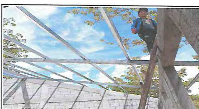
Foto 6: Instalación de la estructura de metal, para sustituir la estructura de soporte de madera por metal, en el aula.
