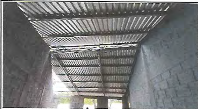
Foto 3: Instalación de lámina troquelada aluzinc calibre 26 con tornillera de fijación, en el aula.
