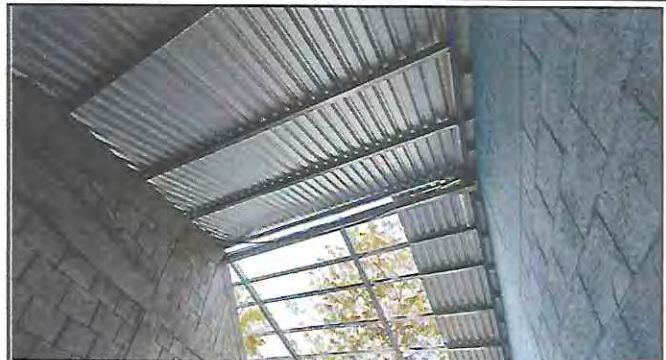
Foto 2: Sustitución de lámina en el aula.
