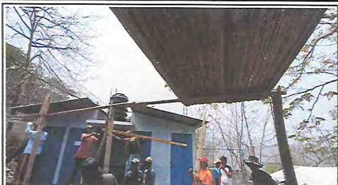
Foto 2: Trabajadores quitando la estructura de madera que se encontraba en malas condiciones.
