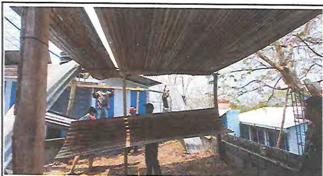
Foto 3: Trabajadores quitando el techo de lámina que se encontraba en malas condiciones.
