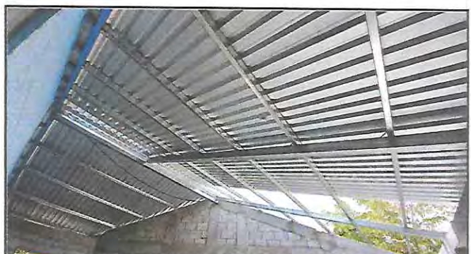
Foto 4: Instalación de lámina troquelada aluzinc calibre 26 con tornillera de fijación, en el aula.
