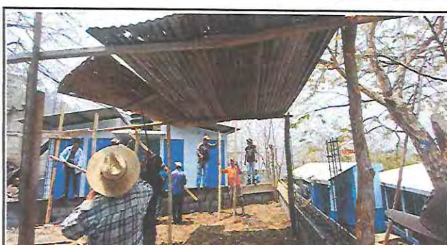
Foto 4: Trabajadores quitando el techo de lámina que se encontraba en malas condiciones.
