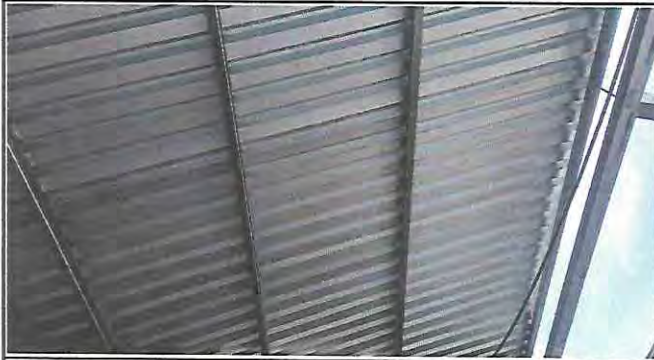
Foto 1: Instalación de lámina troquelada aluzinc calibre 26 con tornillera de fijación en el aula.
