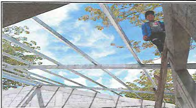
Foto 1: Instalación de costaneras galvanizadas, para sustituir la estructura de soporte de madera por metal en el aula.
