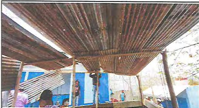
Foto 1: Trabajadores quitando el techo de lámina que se encontraba en malas condiciones.
