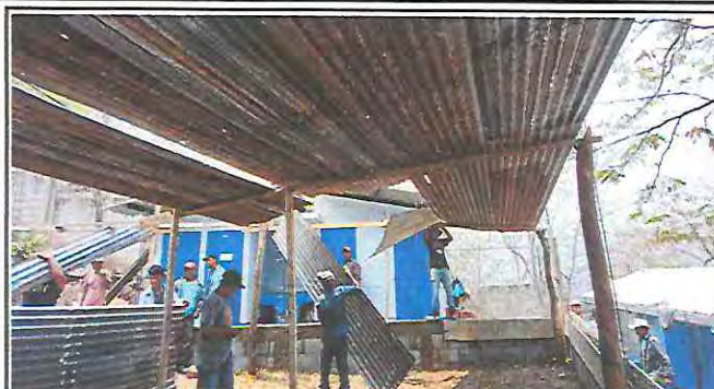
Foto 2: Trabajadores quitando el techo de lámina que se encontraba en malas condiciones.
