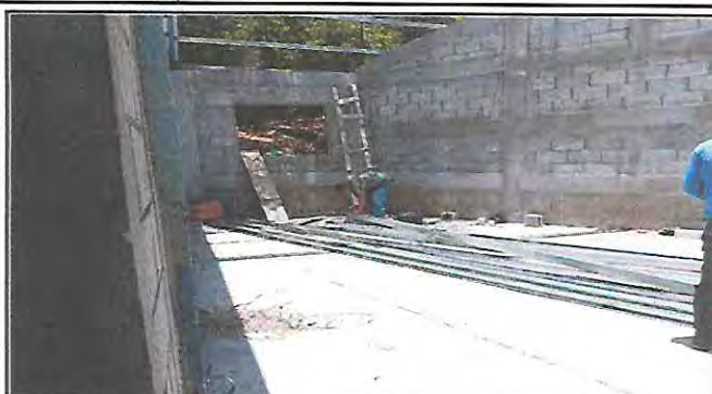
Foto 2: Herrero midiendo las costaneras galvanizadas para su instalación, para sustituir la estructura de soporte de madera por metal, en el aula.
