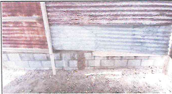
Foto 1: Continuación construcción de paredes del aula
