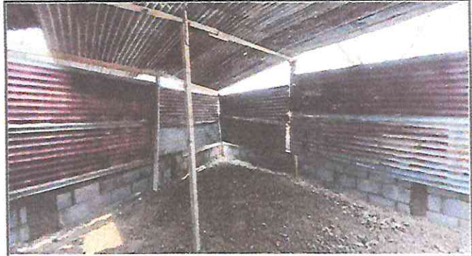
Foto 2: Continuación construcción de paredes del aula, siendo necesario, ya que es inseguro para los estudiantes debido a que se encuentra circulado con lámina.
