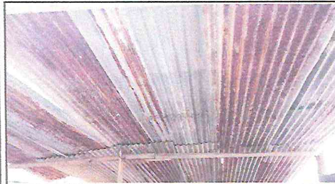
Foto 3: Sustitución de lámina por lámina troquelada aluzinc calibre 26 con tornillera de fijación.
