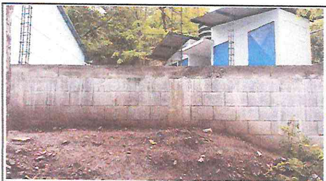
Foto 9: Pared de aula con cuatro hiladas de block y viga a altura de ventana
