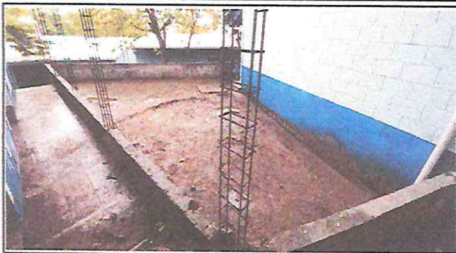
Foto 7: Pared de aulas con nueve columnas a altura de ventana
