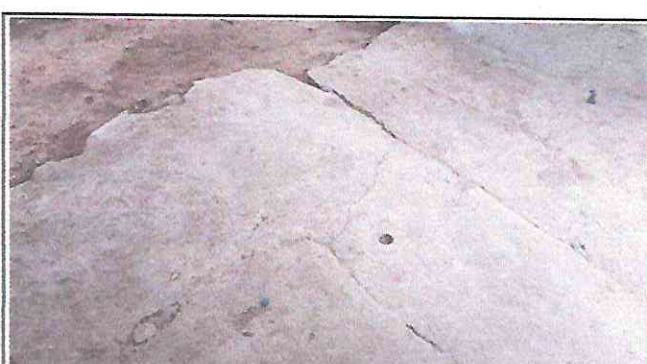
Foto 10: Sustitución de torta de concreto
