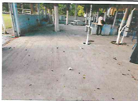
Foto 5: torta de cemento terminada en patio del centro educativo
