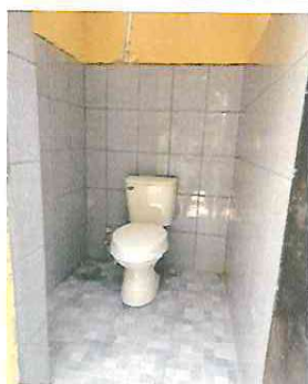
Foto 3: sustituidos los sanitarios proyecto terminando
