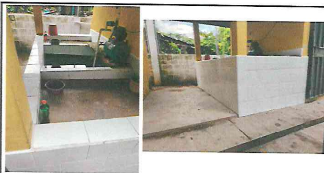
Foto 6: pila terminada de la puesta de azulejo
