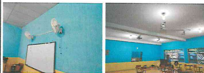
Foto 2: proyecto terminado en la sustitución de los ventiladores
