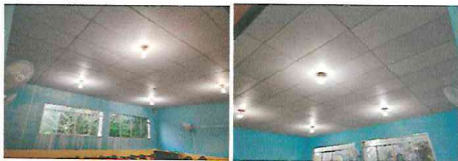
Foto1: terminación de la puesta del cielo falso en las aulas
