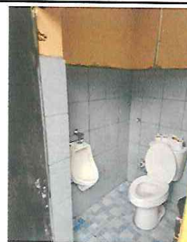
Foto 4: piso y azulejo proyecto terminado en los sanitarios
