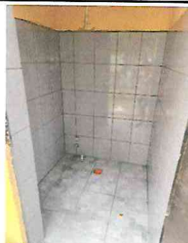
Foto 4: proceso de la instalación del azulejo y piso
