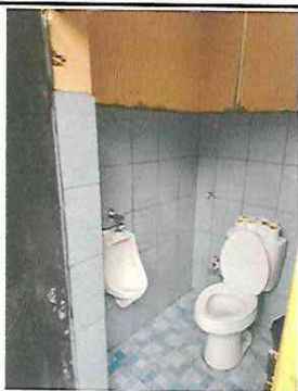
Foto 3: proceso en la instalación de los sanitarios
