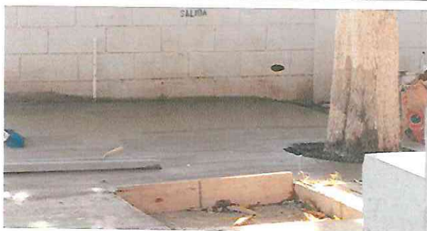
proceso de la torta de cemento en el patio
