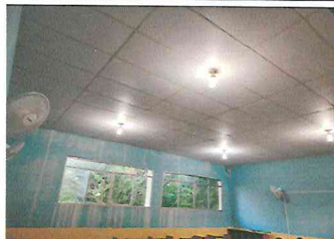
Foto 2: terminación de la colocación de los ventiladores en las aulas
