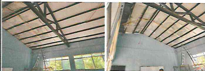
Foto 1: proceso de la instalación del cielo falso en las aulas
