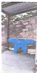
Foto 5: Sustitución de pila
