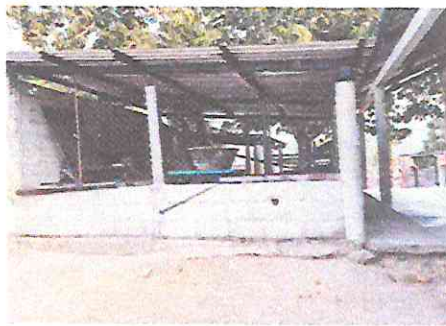
Foto 4: Ampliación de muro en área de cocina
