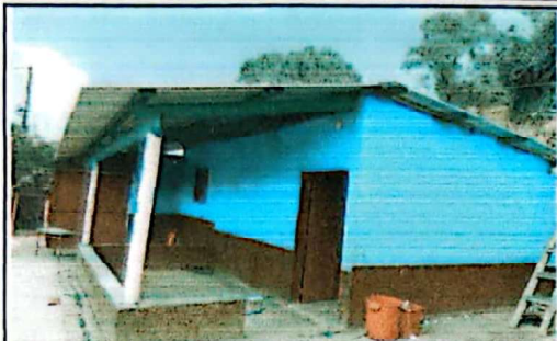
Foto1: SUSTITUCION DE TECHO
