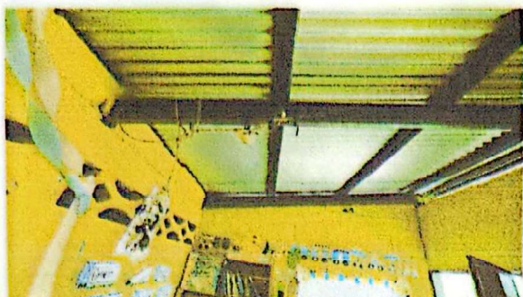
FOTO 1: SUSTITUCIÓN O INSTALACIÓN DE LAMINA Y MANTENIMIENTO DE ESTRUCTURA DE METAL EN AULAS.
