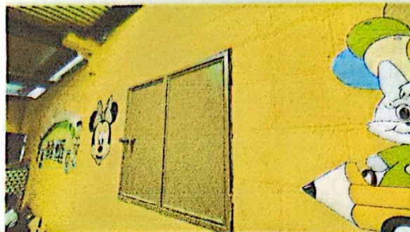
FOTO 2: SUSTITUCIÓN DE VENTANA DE METAL A VENTANA DE PVC EN AULAS.
