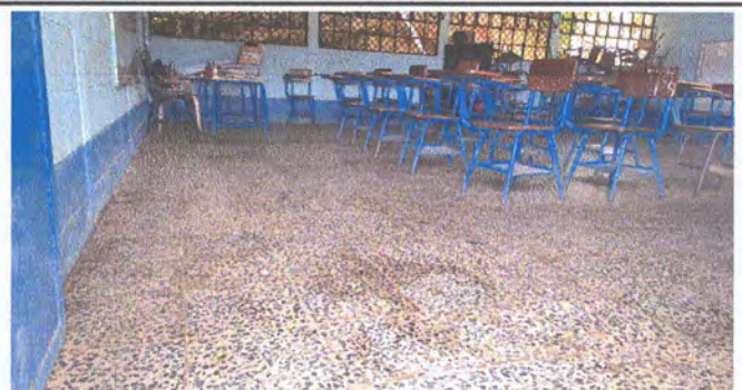
Foto 4: sustitucion de piso por piso ceramica
