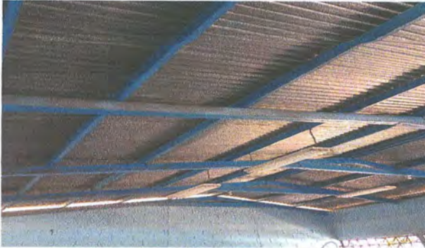
Foto 1: sustitucion de lamina troquelada alucin calibre 20.
