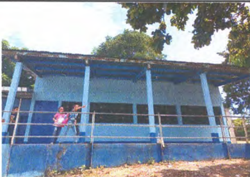
Foto 3: institucion de canal para aguas pluviales con bajadas
