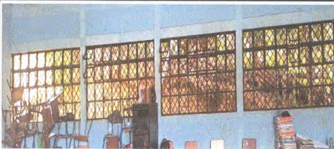
Foto 5: mantenimiento a 8 balcones lijados y pintados
