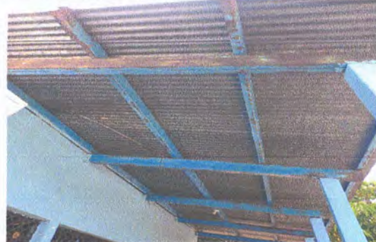
Foto 2: mantenimiento a estructura metalica lijado y pintura.
