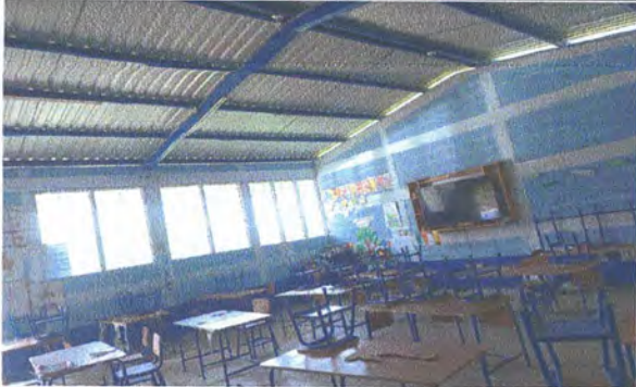
Foto 1: pintar muros exteriores e interiores.
