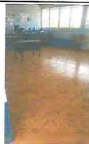
Foto 8: Sustitución de piso de concreto por piso cerámico aula 1
