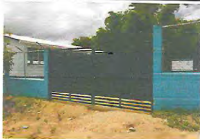
Foto13: Sustitución de porton con medidas de 402 cm de ancho x 216 cm de alto
