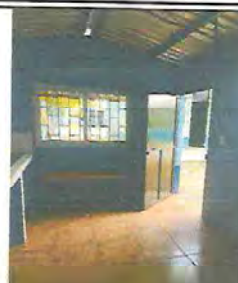
Foto 2: sustitución de ventana de metal por ventana de PVC de 150 X 100 cm
