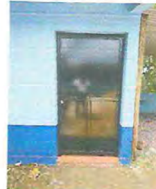
Foto 4: Sustitución de puerta de metal de 200 cm de alto por 100 cm de ancho
