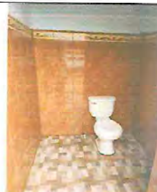
Foto 12: Sustitución de piso de concreto por piso cerámico en baños
