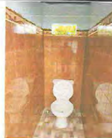
Foto 10: Sustitución de piso de concreto por piso cerámico en baños
