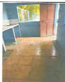
Foto 6: sustitución de piso de concreto por piso cerámico
