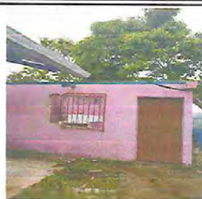
Foto 2: Sustitución de puerta de metal de 200 cm de alto por 100 cm de ancho
