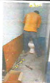
Foto 11: Sustitución de piso de concreto por piso cerámico en baños
