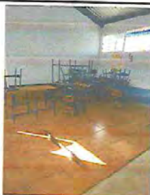
Foto 9: Sustitución de piso de concreto por piso cerámico en el aula 2
