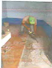
Foto 7: sustitución de piso de concreto por piso cerámico en la Dirección
