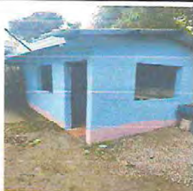
Foto 3: pintura en muros interiores y exteriores de cocina
