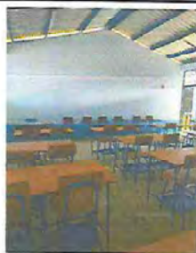
Foto 9 : Sustitución de piso de concreto por piso ceramico en el aula 2
