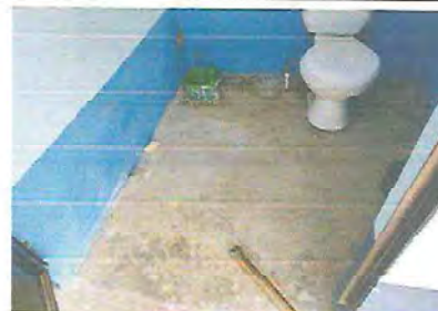
foto 10 : sustitución de piso de concreto por piso ceramico en baños
