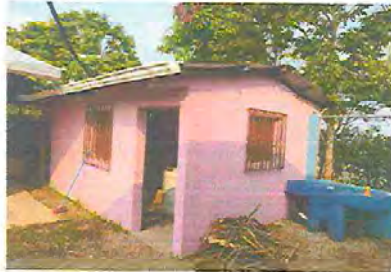
Foto 1: Sustitución de de puerta de meta de 200 cm de alto por 100cm de ancho
