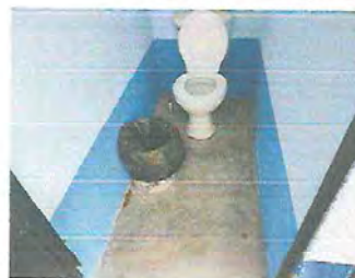
Foto 12: sustitución de piso de concreto por piso ceramico en baños
