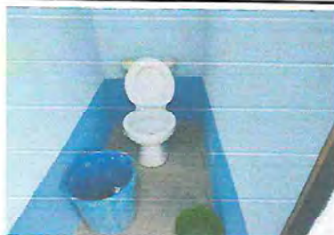
foto 11 : sustitución de piso de concreto por piso ceramico en baños
