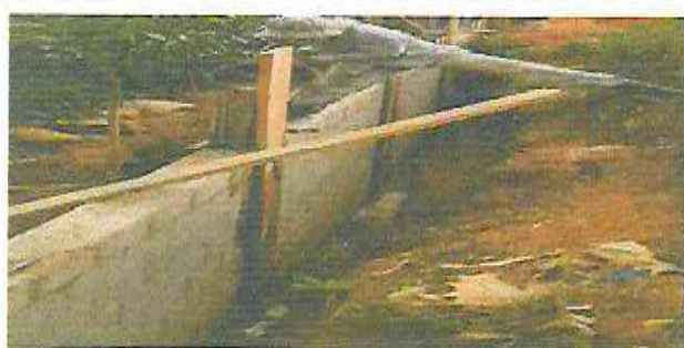
Foto 5: Instalar block con cemento.
