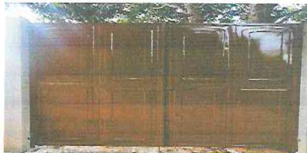
Foto 8: Sustitución de porton principal 3x2.20 con lamina.
