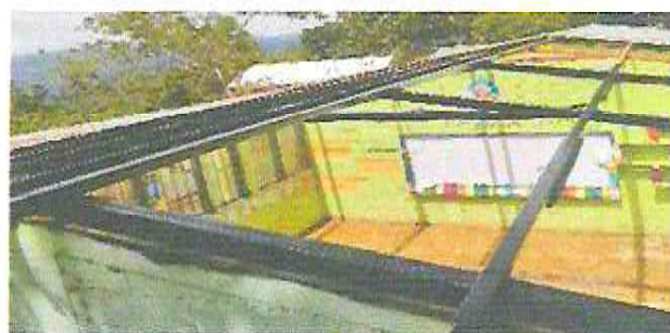
Foto 2: Lijar, limpiar y pintar estructura metalica.
