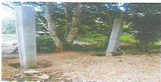
Foto 9: Mejoramiento de porton de madera por columnas de concretos.
