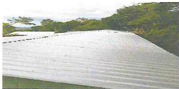
Foto1: Cambio de lamina troquelada alucin calibre 26.
