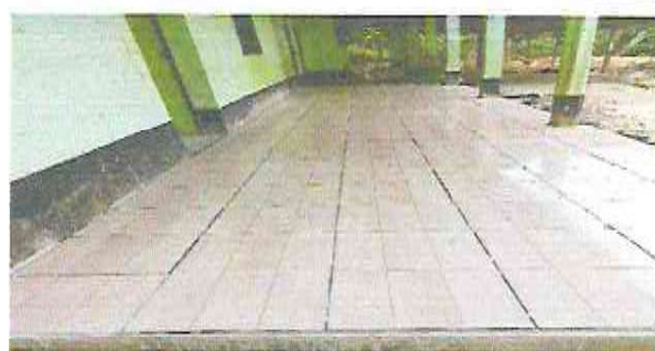
Foto 4: Instalacion de piso ceramico.
