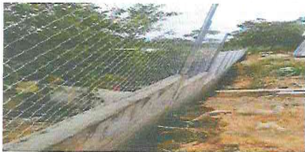
Foto 7: Instalar tubería y maya ciclónica parte de atrás.
