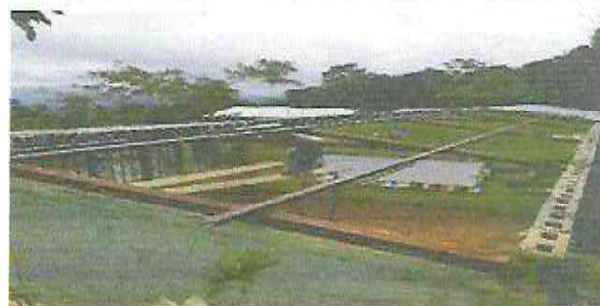
Foto 2: Lijar, limpiar y pintar estructura metálica.
