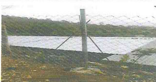
Foto 6: Instalar tubería y maya ciclónica parte de enfrente.
