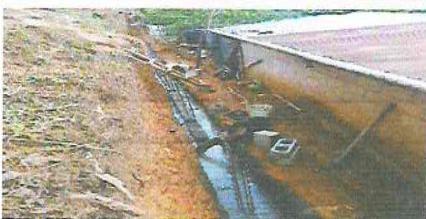
Foto 5: Instalar block con cemento.
