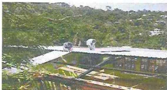
Foto1: Cambio de lamina troquelada alucin calibre 26.
