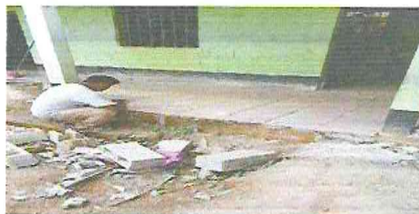
Foto 4: Instalacion de piso ceramico.
