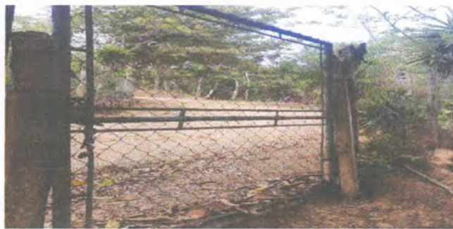
Foto 6: Sustrucción de portón principal.
