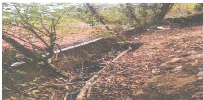
Foto 5: Reparación Muro perimetral de block.
