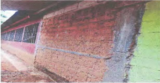
Foto 7: Repello y cernido pared de bodega.
