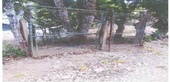
Foto 8: Sustitucion de madera de porton por columna de concreto.
