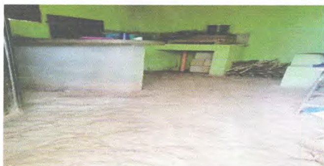
Foto 3: Mejoramiento de Piso de tierra por piso de cemento
