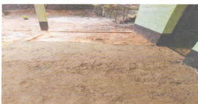
Foto 4: Sustrucción piso cerámico
