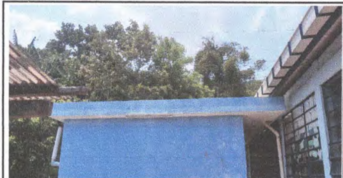
Foto 9: INSTALACIÓN DE DEPÓSITO DE AGUA 1100 LT
