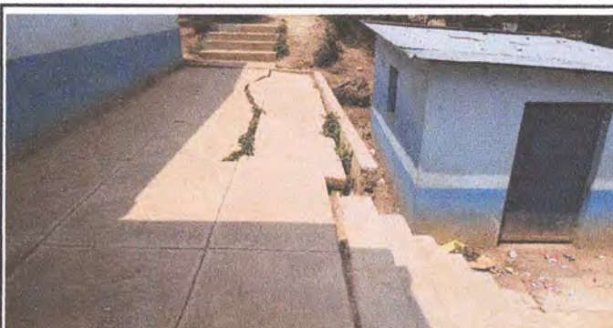
Foto 10: REPARACIÓN DE PLANCHA DE CONCRETO DE BANQUETA
