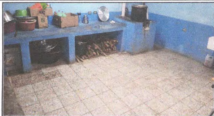
Foto7: INSTALACIÓN DE MESÓN DE TRABAJO
