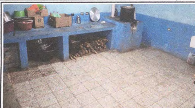
Foto 8: INSTALACIÓN DE AZULEJO EN MUEBLES DE COCINA
