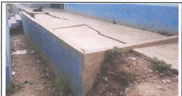
Foto 11: REPARACIÓN DE MURO DE CONTENCIÓN
