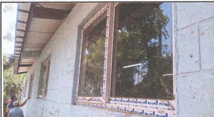
Foto 2: INSTALACIÓN DE BALCONES PARA VENTANA DE PVC
