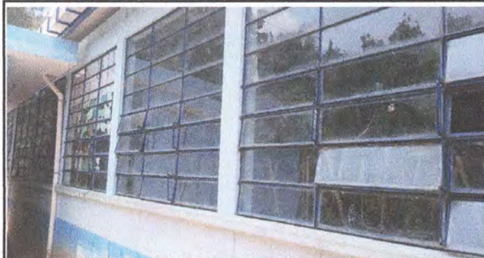
Foto 3: MANTENIMIENTO A ESTRUCTURA DE METAL DE VENTANA
