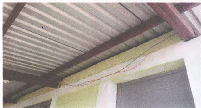
Foto 5: SUSTITUCIÓN DE DUCTO ELECTRICO + ACCESORIOS
