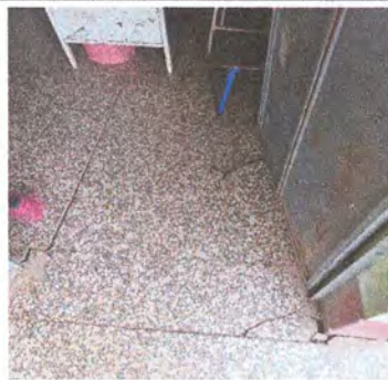
Foto 3: REPARACIÓN DE PISO DE GRANITO
