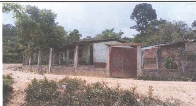
Foto 11: REPARACIÓN DE MURO PERIMETRAL DE BLOCK, CON TUBO HG Y MALLA GALVANIZADA Y COLUMNAS ✓
