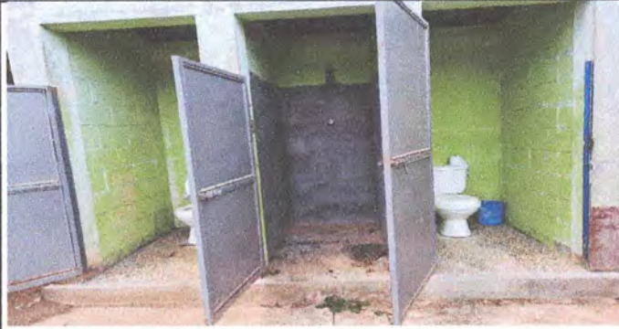
Foto13: INSTALACIÓN DE AZULEJOS
