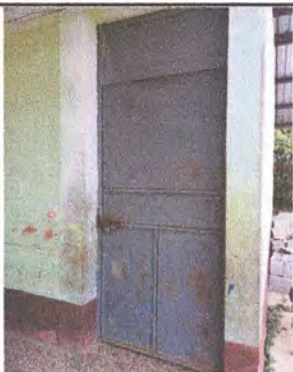
Foto 1: MANTENIMIENTO A ESTRUCTURA DE PUERTA DE METAL
