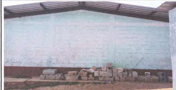
Foto 4: PINTURA EN MUROS EXTERIORES E INTERIORES
