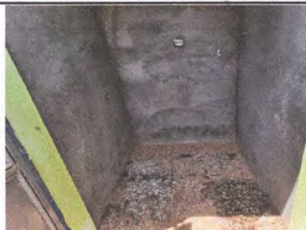
Foto 12: INSTALACIÓN DE INODORO ✓
