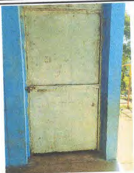
Foto 1: Sustrucción de puertas en bodega.
