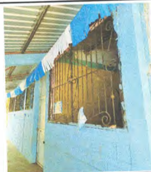
Foto 2: Instalación de balcon reforzado en bodega para evitar más robos.
