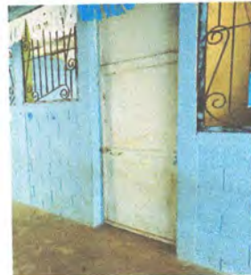
Foto 6: Mantenimiento de puerta con chapa modulo 1.
