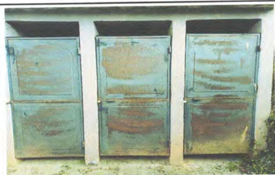
Foto 3: Reparación y pintura de puertas de 6 baños.
