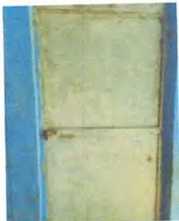
Foto 3: Sustrucción de puertas en cocina.
