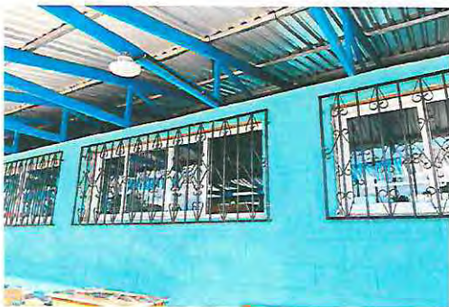
Foto 3: Instalación de ventana de PVC Aula 1
