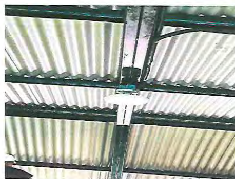
Foto 12: Mantenimiento a estructura de soporte de metal
