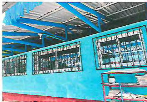
Foto 4: Instalación de ventana de PVC Aula 2
