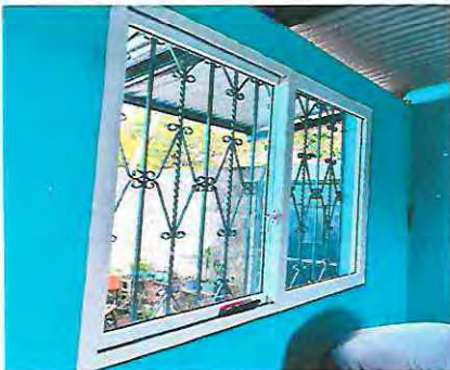
Foto 13: Mantenimiento a balcones de metal
