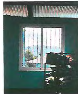
Foto 14: Instalación de ventana de PVC
