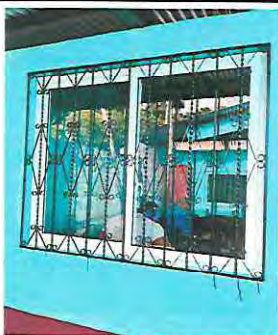
Foto 5: Instalación de ventana de PVC Aula 3
