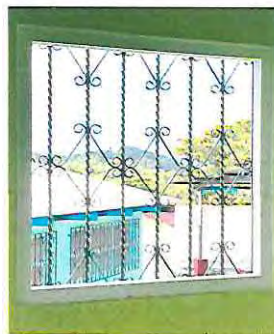
Foto 2: Mantenimiento a balcones de metal Aula 3
