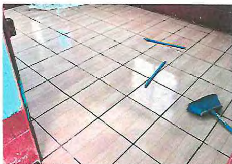
Foto 9: Sustitución de piso de granito por piso ceramico Dirección
