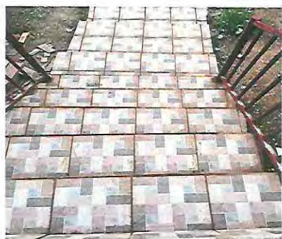
Foto 11: Sustitución de piso de torta de concreto por piso ceramico en gradas de ingreso
