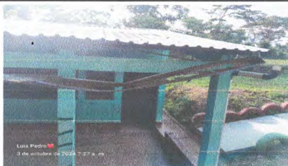
Foto 11: Sustitución de canal de PVC y colocación de base de metal para atornillar soportes.
