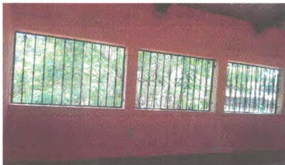
Foto 7: Mantenimiento de balcones de metal.
