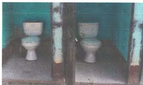
Foto 4: Sustitución de piso cerámico.
