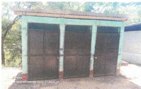
Foto 3: Mantenimiento de estructura (lijado, cambio de tubo, aplicación de pintura, cambio de visagras) en puertas de servicios sanitarios, 1.00 x 2.00
