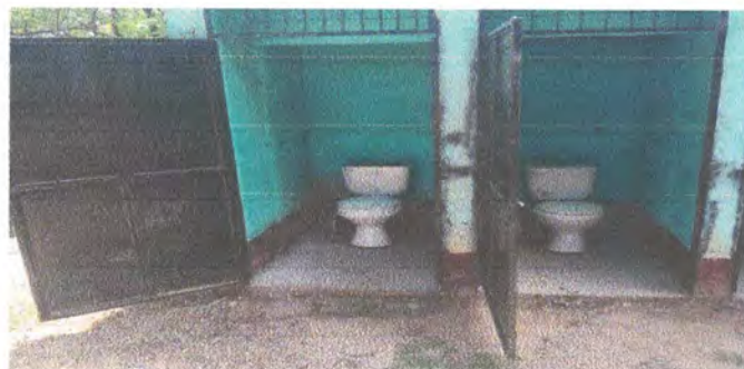
Foto 2: Sustitución de inodoros.
