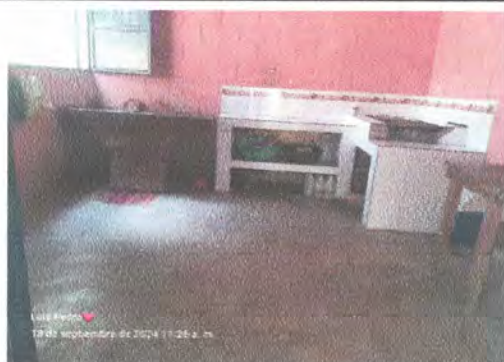
Foto13: Sustitución de piso ceramico a cocina
