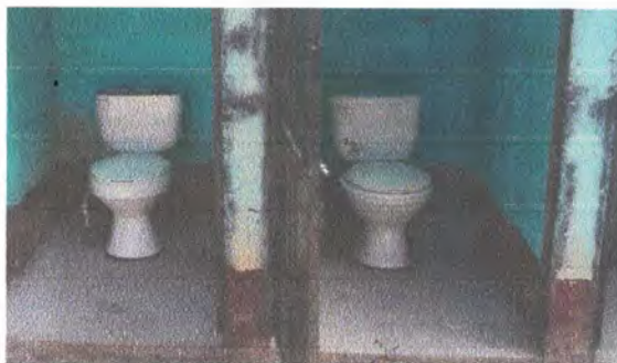
Foto 5: Sustitución de azulejo en servicios sanitarios.
