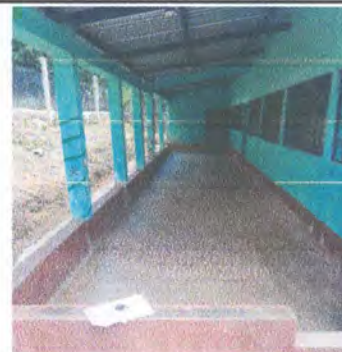
Foto 12: Sustitución de piso cerámico.
