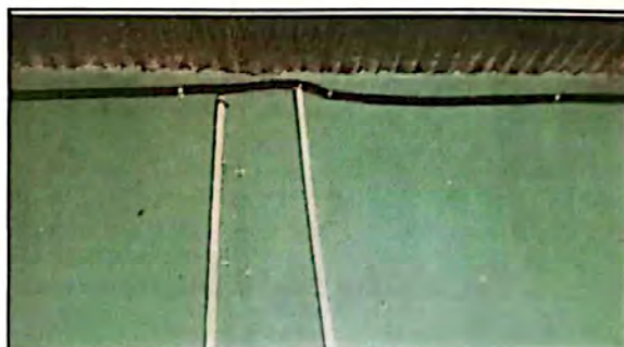
Foto 10: Sustitución de ducto eléctrico + accesorios
