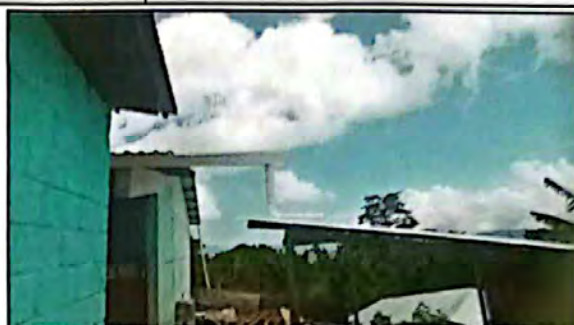
Foto 8: Sustitución de canales metálicos por canales de pvc y bajada de agua pluvial de pvc
