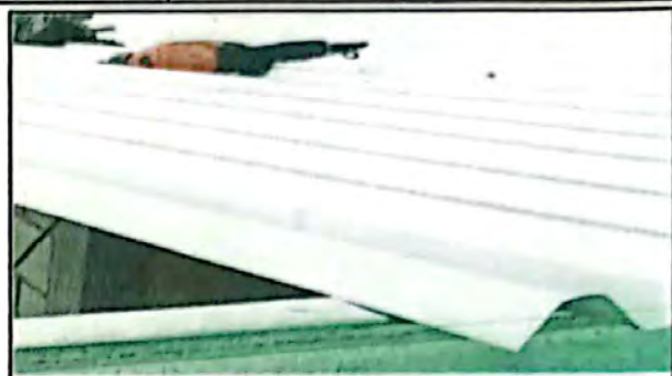
Foto 2: Sustrucción de elementos de fijación
