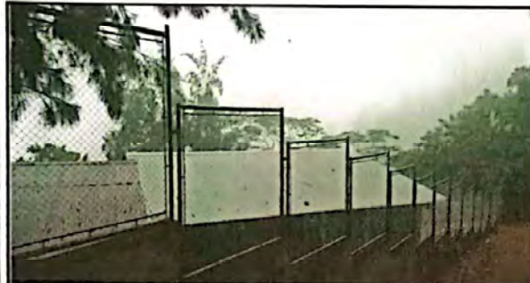
Foto 5: Sustrucción de tubo hg y malla galvanizada
