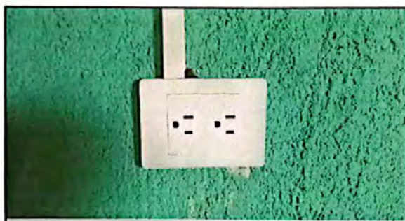
Foto 11: Sustitución de tomacorrientes dobles
