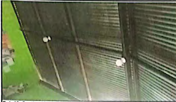
Foto 13: Sustitución de lámparas tipo LED
