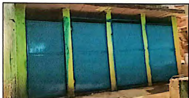
1. Mantenimiento a puertas (lijado, cepillado, aplicación de pintura)
