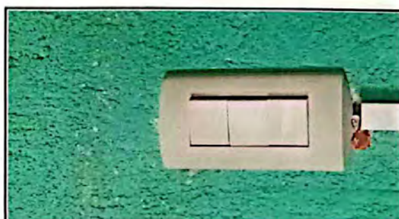
Foto 12: Sustitución interruptores simples
