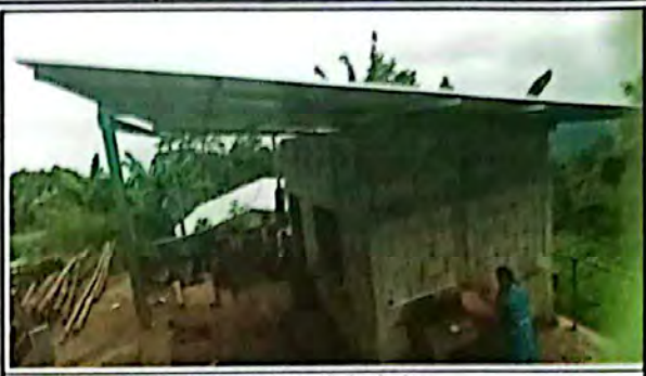
Foto 14: Instalación de lámina troquelada aluzinc
