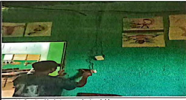
Foto 11: Sustitución de tomacorrientes dobles
