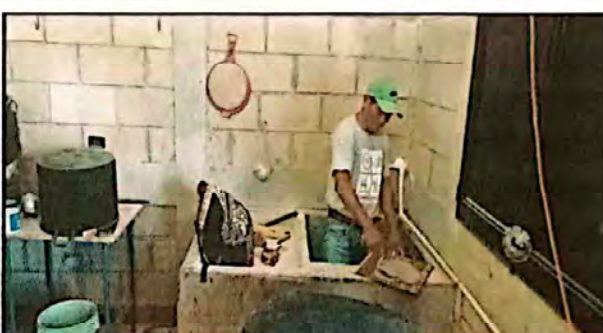
Foto 4: Instalación de azulejo en pila de cemento y mesa de trabajo
