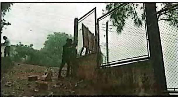
Foto 5: Sustitución de tubo hg y malla galvanizada
