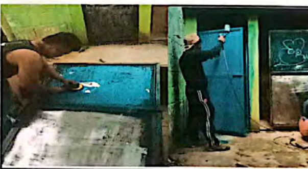
1. Mantenimiento a puertas (lijado, cepillado, aplicación de pintura)
