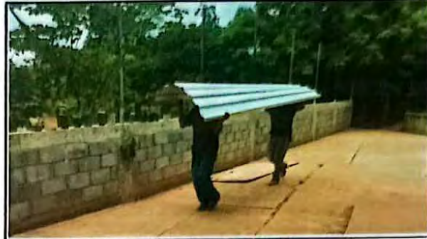
Foto 14: Instalación de lámina troquelada aluzinc
