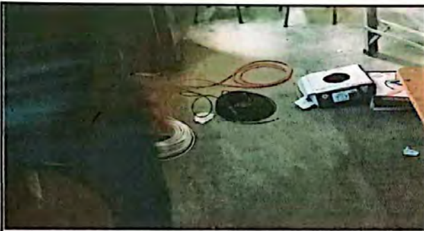
Foto 9: Sustitución de cableado eléctrico
