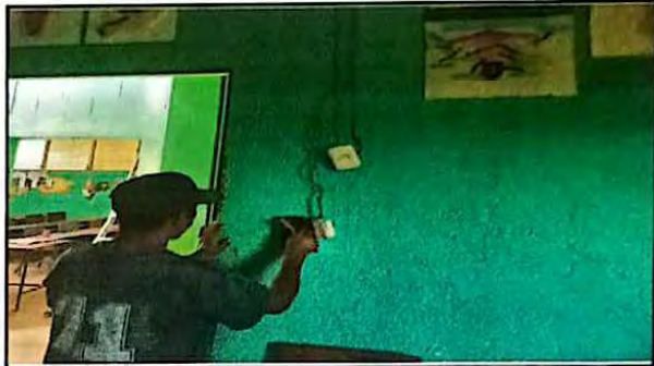
Foto 16: Instalación de unidades fuerza
