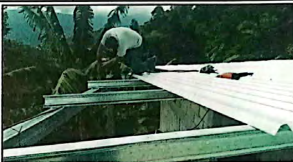
Foto 2: Sustitución de elementos de fijacion
