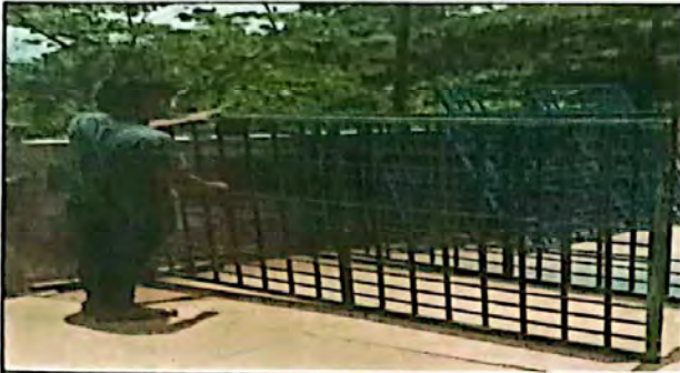
Foto7: Mantenimiento a balcones de metal
