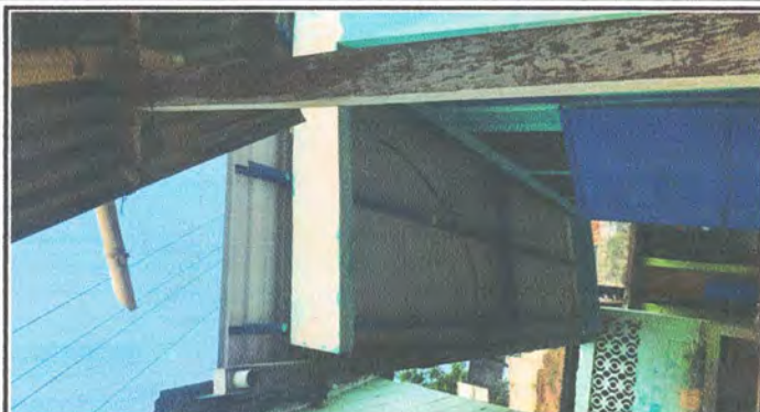
Foto 8. Sustitución de canales metalicos por canales de pvc y bajada de agua pluvial de pvc
