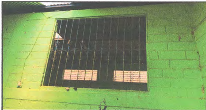
Foto 7: Mantenimiento a balcones de metal
