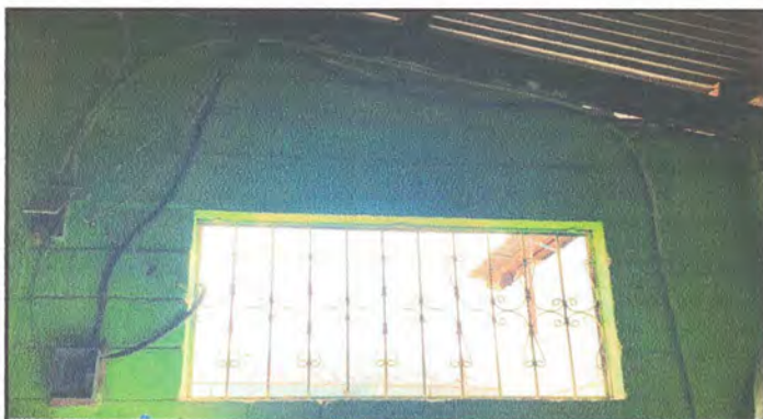
Foto 9: Sustitución de cableado electrico
