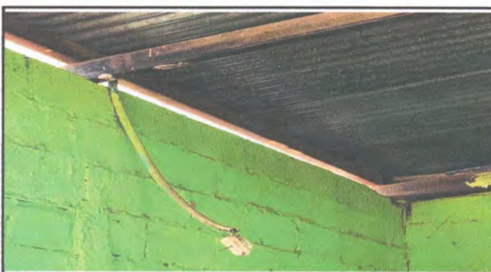
Foto 10: Sustitución de ducto eléctrico + accesorios
