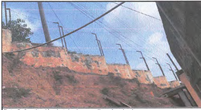
Foto 5: Sustrucción de tubo hg y malla galvanizada
