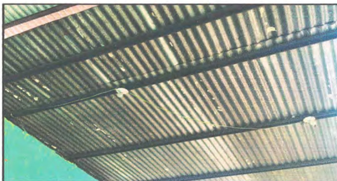
Foto 15: Instalación de unidades luz
