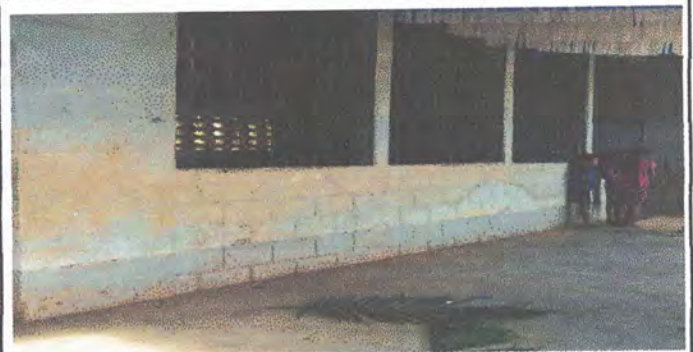
Foto 2: Los balcones del salón de clases, se encuentran deteriorados porque varios de los barrotes ya se encuentran desprendidos del balcón, también necesitan una limpieza y pintura.
