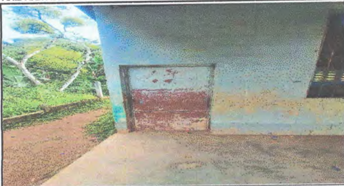
Foto 1: En esta fotografía se evidencia el deterioro de la puerta del salón de clases, la puerta no se puede abrir porque está podrida.
