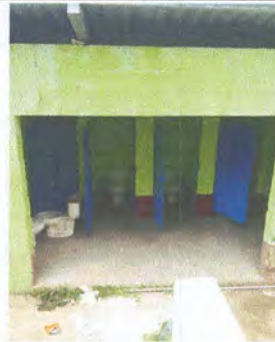
Foto 4: Se instalara azulejo y ceramico antideslizante en los baños
