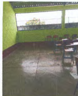
Foto 2: Se Sustituira el piso de concreto por piso ceramico en el aula #2
