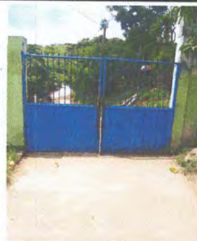
Foto 8: Se le dara mantenimiento al porton principal
