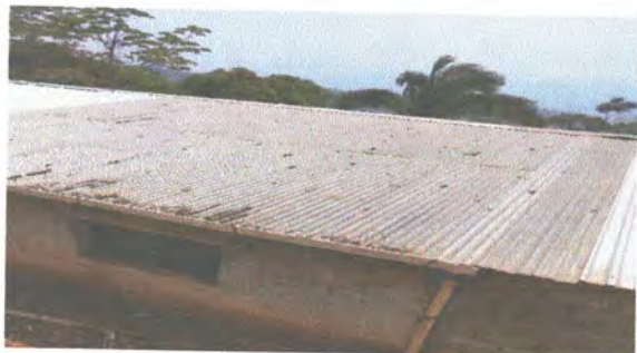
Foto 1: Sustrucción de lamina, por lámina troquelada calibre 26.
