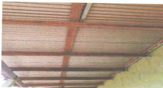
Foto 2: Sustrucción de madera, por estructura metalica.
