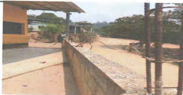
Foto 4: Instalacion maya maya perimetral con tubo redondo.
