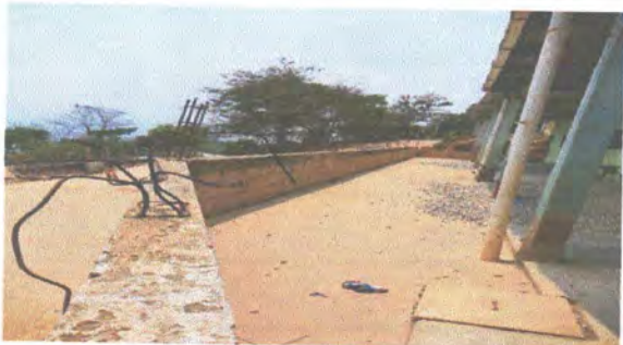
Foto 3: Mejoramiento muro perimetral.
