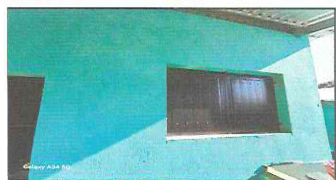
Remodelación de la ventana de 1.5x2
