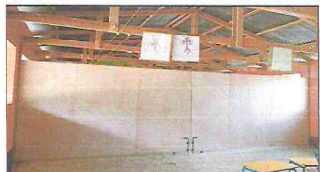
Cambio de división de madera tratada y plyvoo de 1/2 con rodos
