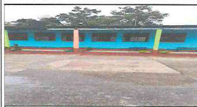
Pintura general aulas, baños y cocina
