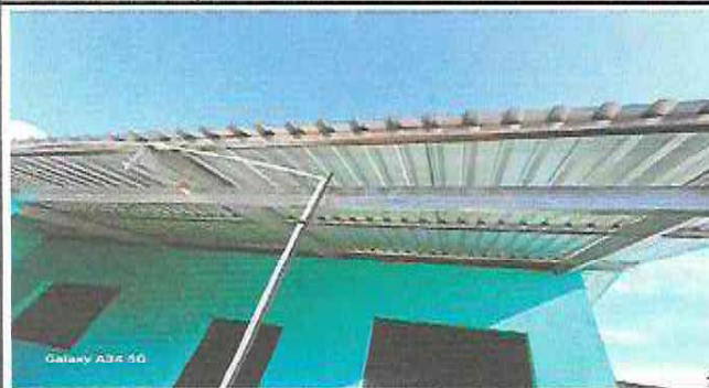
Cambio de lámina troquelada alucin calibre 26 y cambio de estructura metálica
