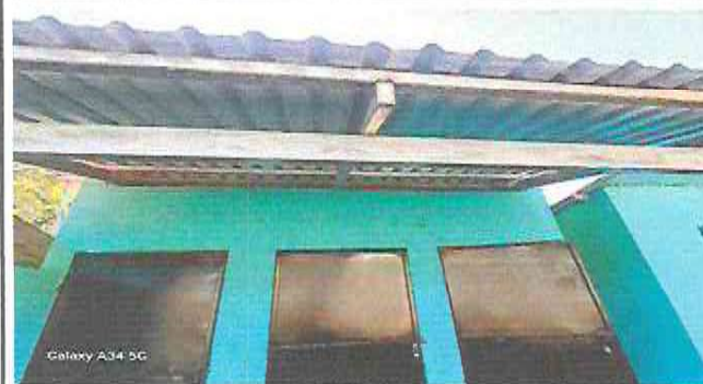
Cambio de lámina por lámina troquelada alucin calibre 26 y estructura de madera por estructura metálica
