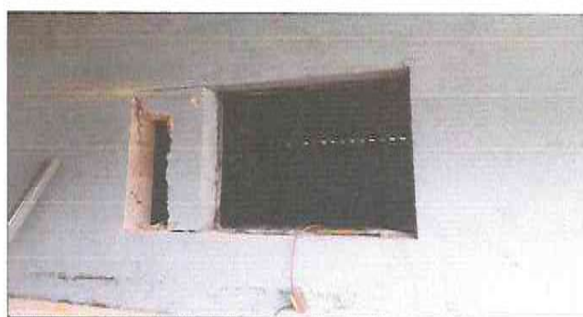
Durante la remodelación de la ventana de 1.5 x 2
