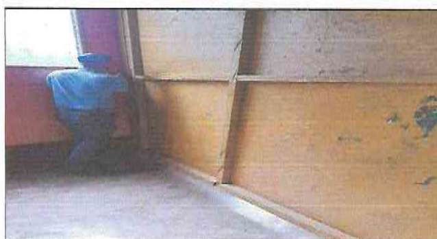
Durante el cambio de división de madera tratada y Plyvoo de 1/2 con rodos
