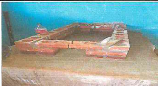
Durante la construcción de la plancha con chimenea
