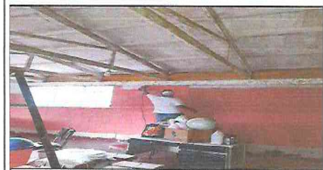
Durante la pintura general aulas, baños y cocina
