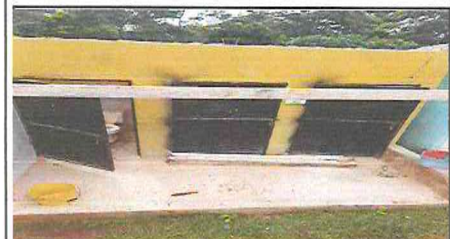
Durante el cambio de lámina por lámina troquelada alucin calibre 26 y estructura de madera por estructura metálica
