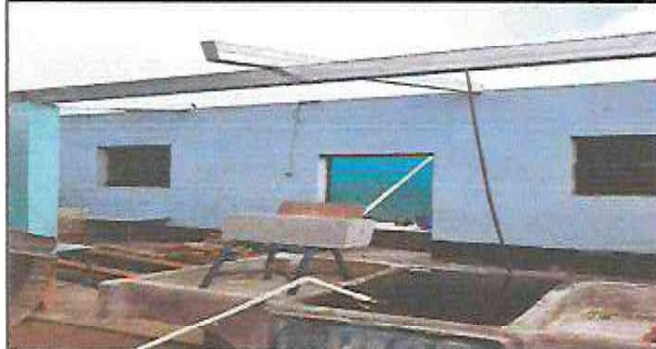
Durante el Cambio de lámina troquelada alucin calibre 26 y cambio de estructura metálica
